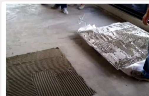
STEP2：以慢刀在磁磚及地板塗上磁磚黏著劑
